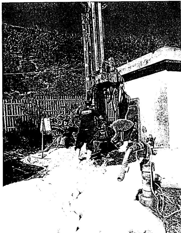
una sonda di piccolo diametro, utilizzata probabilmente per liberare le sabbie incrostanti e quindi finalizzata alla pulizia dello stesso. Si provvede a spingere il sondino incagliato, con il martello fondo foro, ad una maggiore profondità possibile, arrestando l'infissione alla profondità di 86 metri circa dal piano di campagna.
